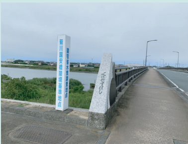
県道372号線 国安橋。
