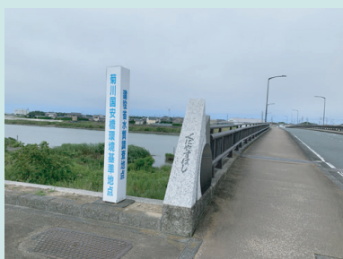
県道372号線 国安橋。
